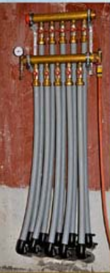
Grupisanje sonde pre povezivanja sa toplotnom pumpom
