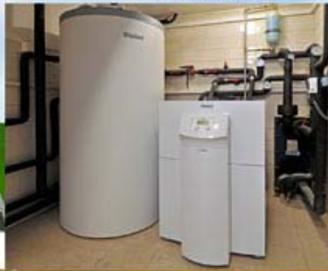
Vaillant GeoTHERM VWS 300/2 geotermalna toplotna pumpa i akumulacioni bafer
