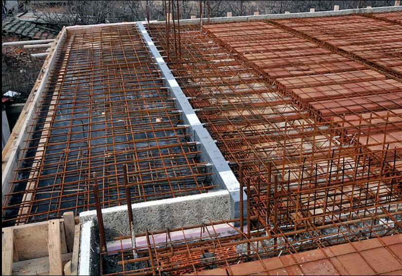
Nosivi toplotni prekid za balkone
