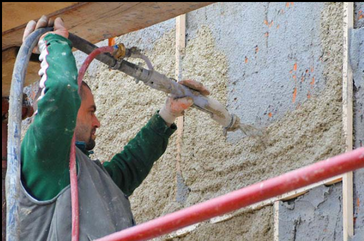
Fasada sa termo-malterom od 4cm za poboljšanje toplotne performanse (perlit)
