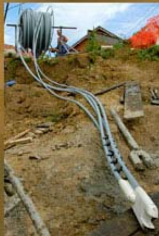
5 vertikalnih geotermalnih sonde koje idu 100m u zemlju
