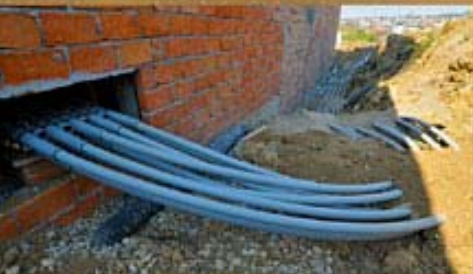
Ulazak vertikalnih geotermalnih sonde u podzemni parking
