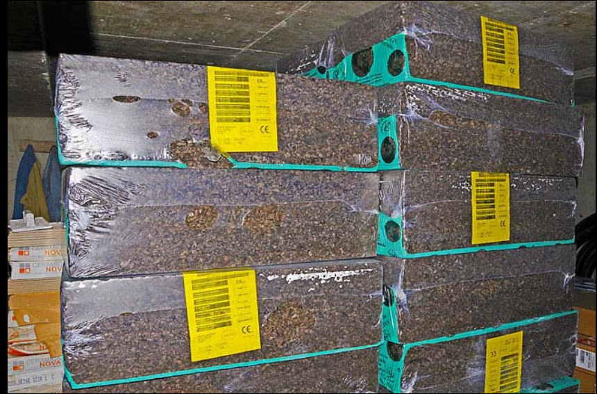
Obloge od industrijske plute za zvučnu izolaciju unutrašnjih zidova
