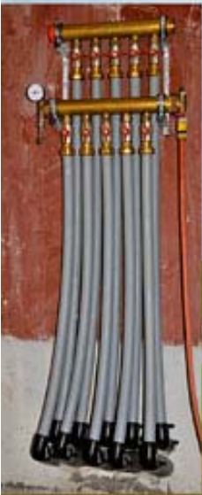
Grupisanje sondi pre povezivanja sa toplotnom pumpom
