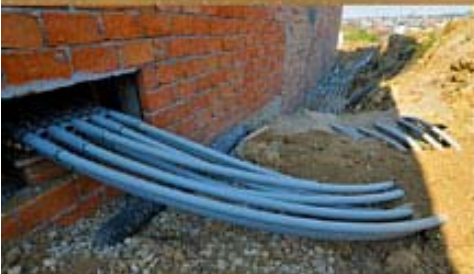
Ulazak vertikalnih geotermalnih sondi u podzemni parking
