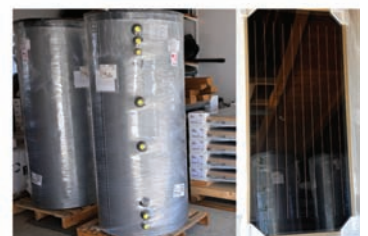
Bojleri za sanitarnu toplu vodu (2x5000) i solarni kolektori za Amadeo. Sanitary hot water cylinders (2x5000) and solar collectors for Amadeo.
