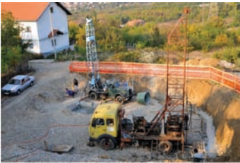
2 mašine za bušenje prave bušotine za geotermalni sistem za Amadeo. 2 drilling rigs making the boreholes for the geothermal system of Amadeo.
